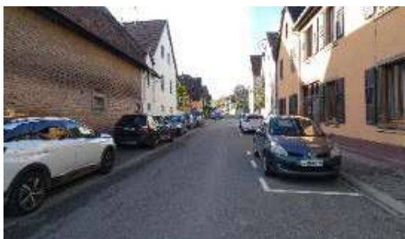
RUE DE LA MONTEE : Création d'une « zone de rencontre » dans les rues du moulin et des argiliers et d'une « zone 30 » dans les rues du noyer, des érables, des ormes, des charmes et de la montée. Dans cette dernière des cases de stationnement ont été marquées au sol afin d'interdire le stationnement hors cases et de ralentir la circulation.
