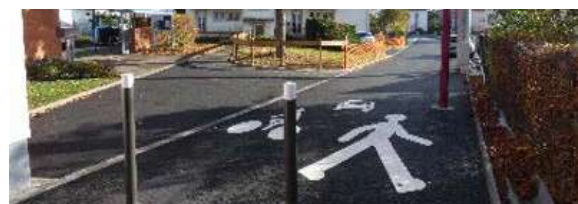
RUE DE L'ECOLE : Les travaux de renouvellement des enrobés de la rue de l'école, réalisés pendant les vacances scolaires de cette année seront complétés par des marquages ludiques définis par les enfants de l'école primaire dans le cadre d'un projet pédagogique au courant de l'année 2021 .
