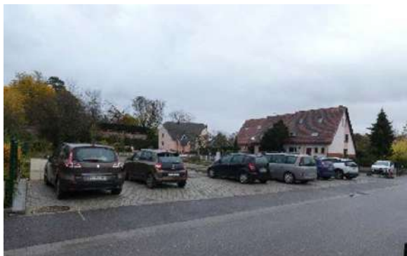
PARKING RUE DU MOULIN : Création d'un parking de 8 places en pavés drainants permettant l'infiltration sur place des eaux pluviales.
