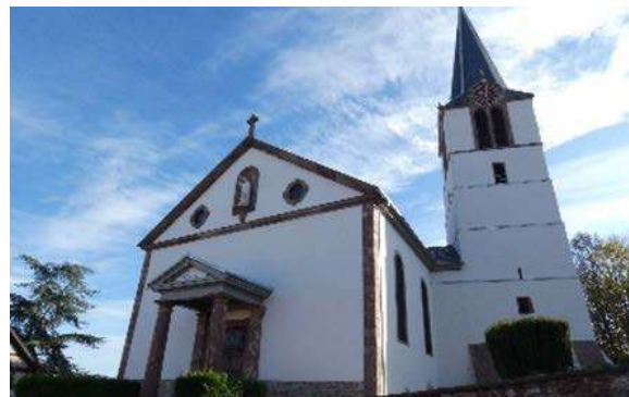
EGLISE : Les travaux de ravalement des façades de l'église, démarrés fin 2019 ont été freinés par la réalisation de travaux supplémentaires et urgents à réaliser sur la charpente ainsi que par des travaux d'étanchéité. Arrêtés pendant le confinement à partir de mars, les travaux ont repris au courant de l'été et se sont terminés au mois d'octobre.
